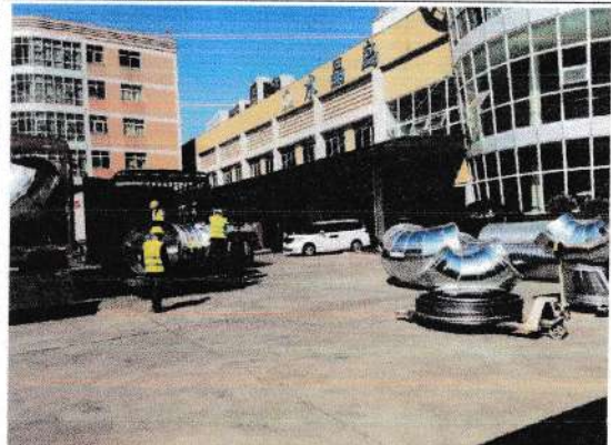
前端收集风管制作安装
